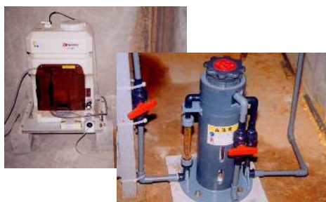
(左) 次亜塩素酸ナトリウム溶液用の消毒装置 (右) 固形剤消毒薬用の消毒装置
