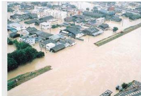
図 1.6 平成12月9月洪水被害状況
