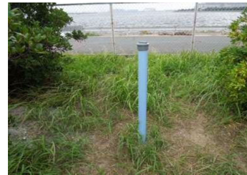
観測井戸No.2 (南東側)
