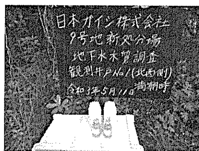
日本ガイシ知多事業所 9号地産業廃棄物処分場新設 工事における地下水水質調査 〈写真説明〉 観測井No.1(北西側) 【湧出時】 採取採取 調査日: 令和3年5月11日
