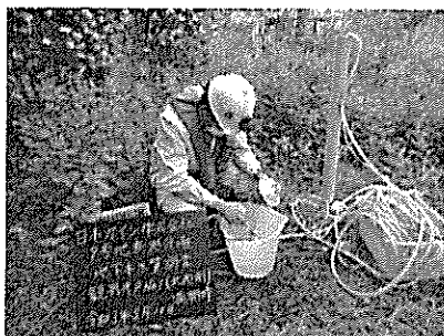
日本ガイシ知多事業所 9号地産業廃棄物処分場新設 工事における地下水水質調査 〈写真説明〉 観測井No.1(北西側) 【湧出時】 採取採取状況 調査日: 令和3年5月11日
