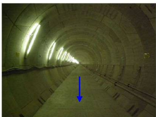
⑤青木川放水路函体工
