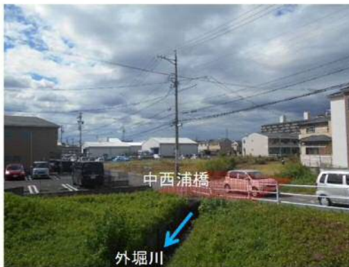
⑨外堀川：橋梁改築工事
