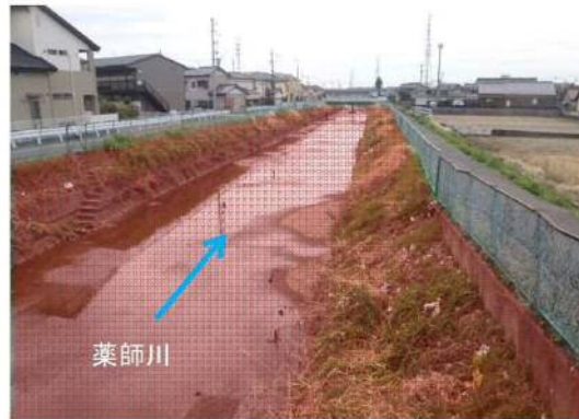
⑧薬師川：河道整備
