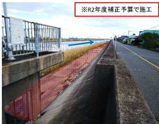
①新川：堤防の耐震化工事
