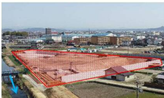
⑪青木川（第4調節池 築造工）
