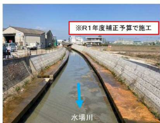
③水場川：護岸工事（西流橋付近）
