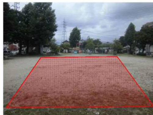
⑫新川（井領公園）：流域貯留施設工（着手前）
