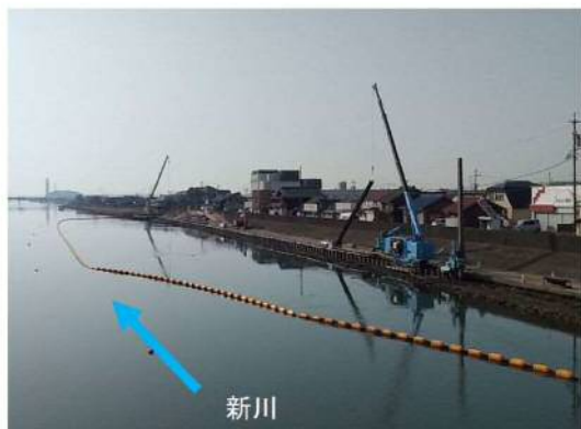
①新川：堤防の耐震化工事
