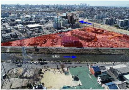
⑦地蔵川：排水機場の整備
