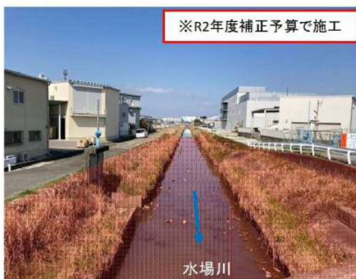
③水場川：護岸工事（西流橋付近）
