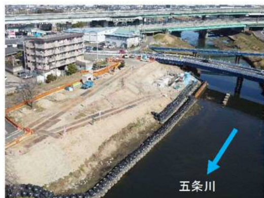
②五条川：清洲橋改築工事
