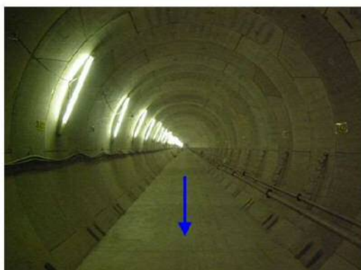
⑤青木川放水路函体工事
