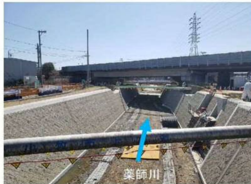
⑧薬師川：河道整備
