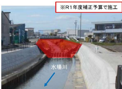
③水場川：河道整備（西流橋付近）
