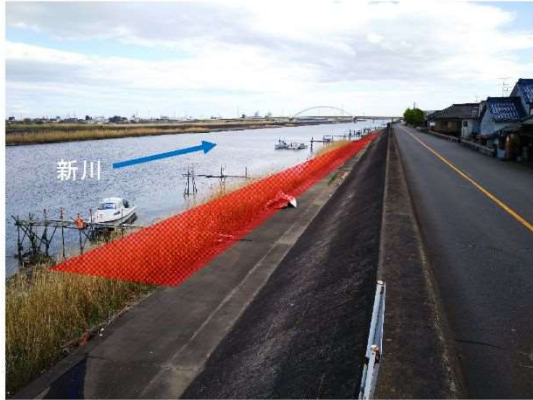
①新川：堤防耐震化
