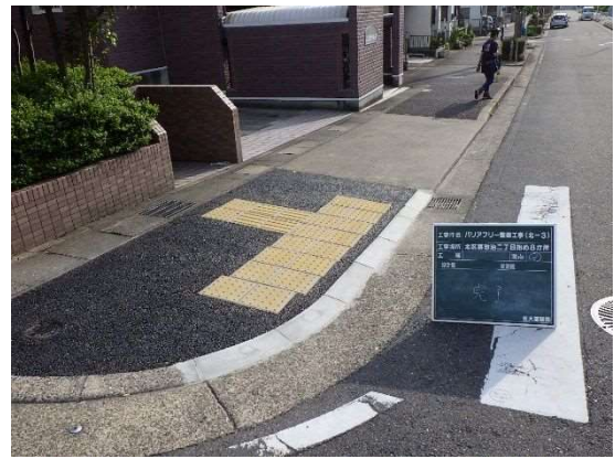
透水性舗装（名古屋市）
