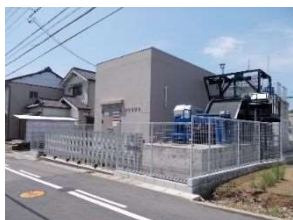
イ.向町ポンプ場
