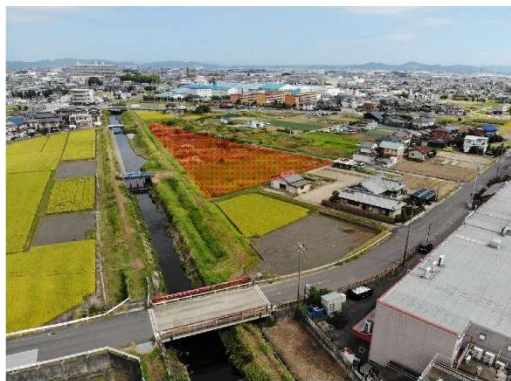
④青木川：第4号調節池整備
