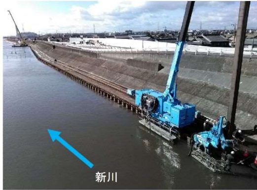
①新川：堤防耐震化
