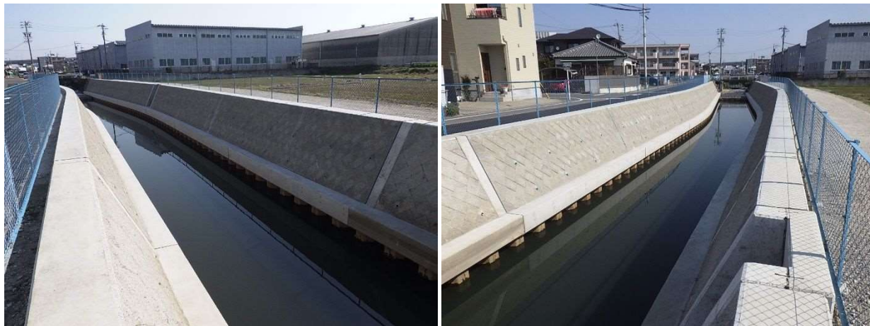
準用河川千間堀川改修（一宮市）
