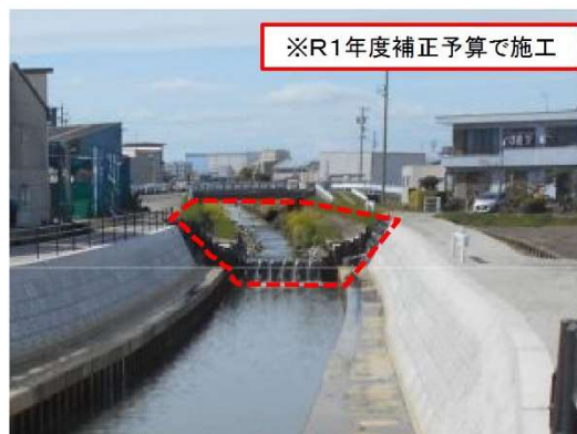
③水場川：河道整備（西流橋付近）
