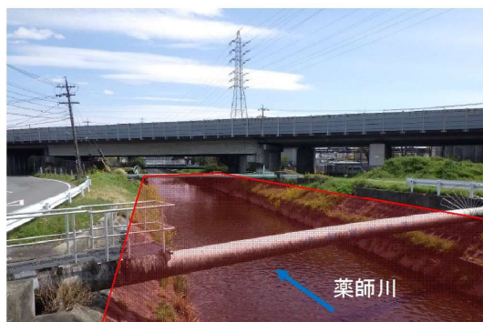
⑨薬師川：河道整備
