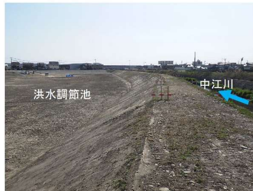
④中江川：調節池整備（完成）
