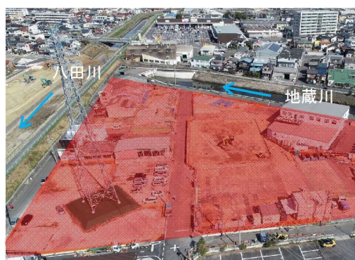
⑧地藏川：排水機場（用地補償及び工事）
