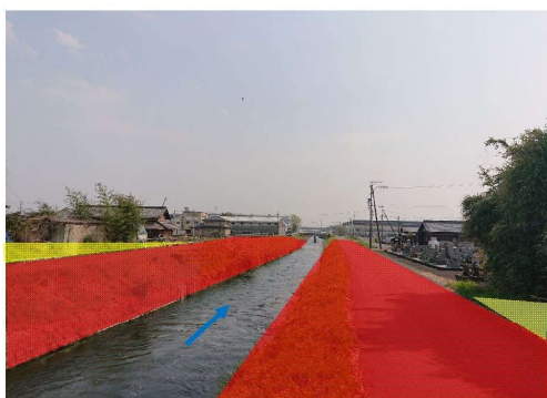
⑦合瀬川：用地補償及び河道整備
