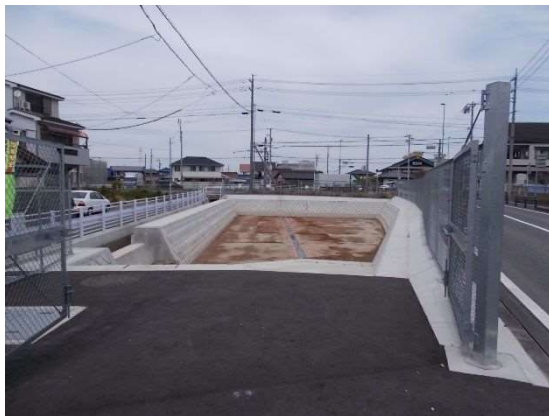
北部給食センター貯留施設（小牧市）
