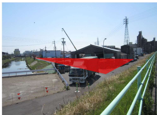
⑨地蔵川：排水機場予定地（用地補償及び工事）
