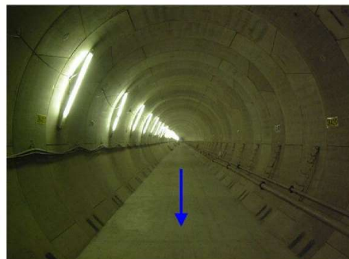
⑥青木川放水路施工中
