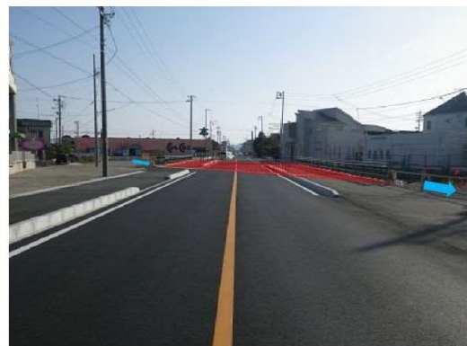
⑥青木川：橋梁改築
