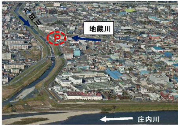
⑦地蔵川：排水機場建設予定箇所
