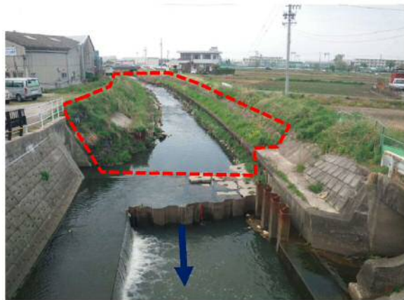
③水場川：護岸工事
