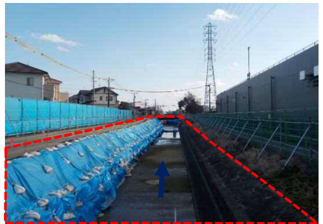
⑩薬師川：護岸工事
