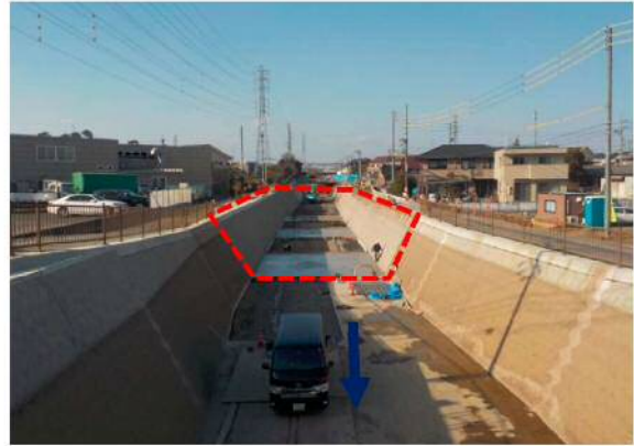
⑧薬師川：護岸工事
