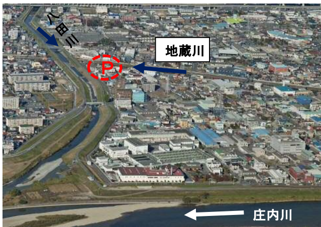
⑨地蔵川：排水機場建設予定箇所
