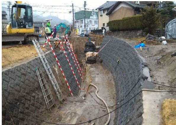
準用河川道木川改修（小牧市）
