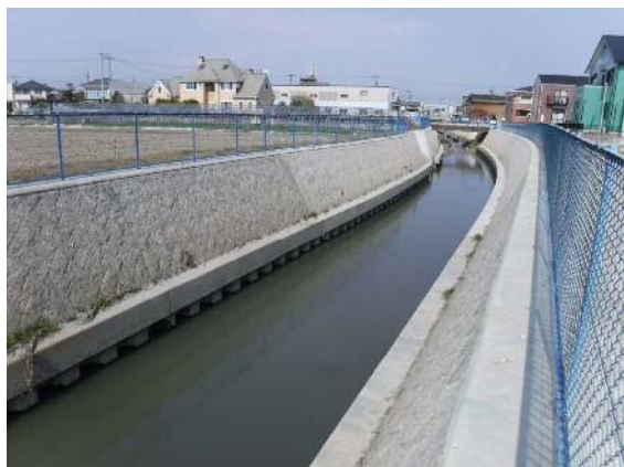
準用河川千間堀川改修（一宮市）
