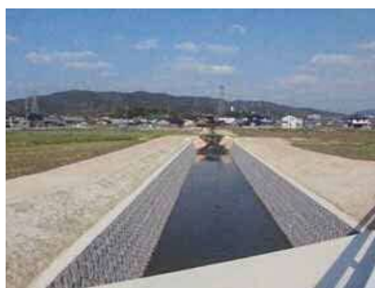
準用河川道木川改修（小牧市）
