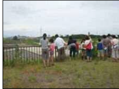
新川治水緑地洗堰 (名古屋市内)
