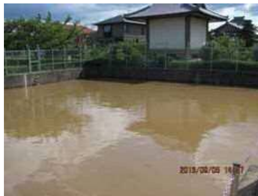
貯留施設の貯留状況 (約1,500 m^3 、稲沢市、H25.9.4)
