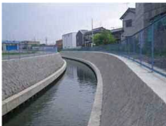
準用河川千間堀川改修（一宮市）
