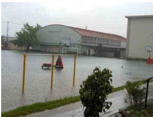
学校貯留の貯留状況 (約700 m^3 、一宮市、H25.9.4)
