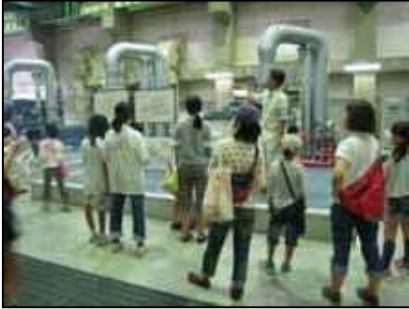
青木川放水路排水機場 (江南市内)
