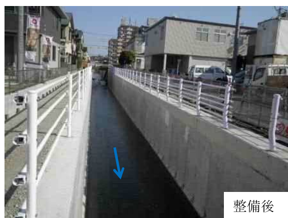
新境川改修状況(小牧市地内)
