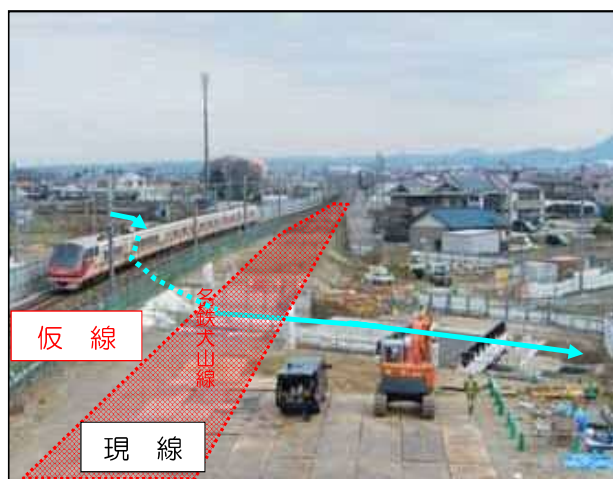
⑥-2青木川上流：河川改修に伴う名鉄犬山線橋梁の架け替え工事施工箇所 (本線復旧工事)
