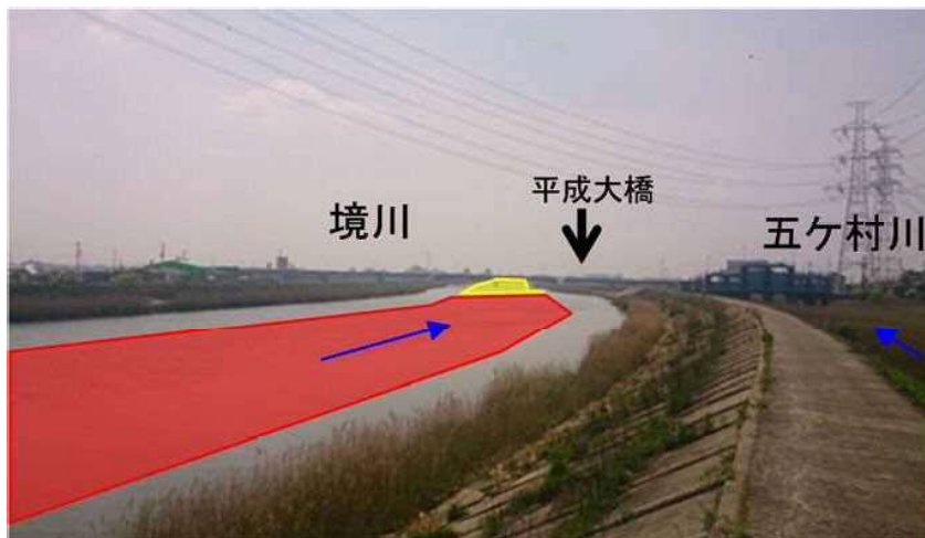
③境川：河床掘削予定箇所及び河床掘削のイメージ
