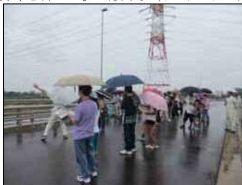
逢妻川改修現場（刈谷大府線付近）
