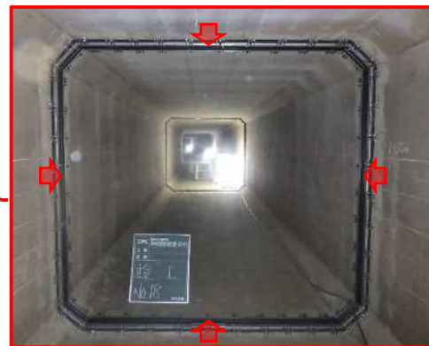
滑走路直下の幹線排水路の耐震対策工事【県営名古屋空港】
