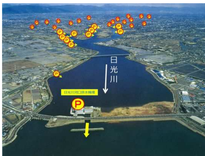
ゼロメートル地帯を守る農業用排水機場
