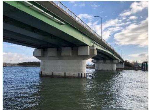
豊橋臨港道路6号線 神野大橋の耐震化(豊橋市)
