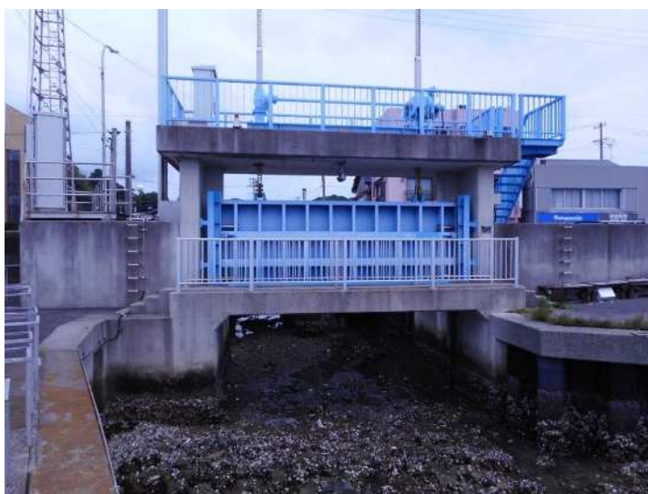
師崎川樋門（南知多町）
