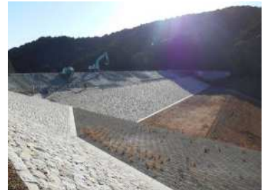
ため池の耐震工事状況
