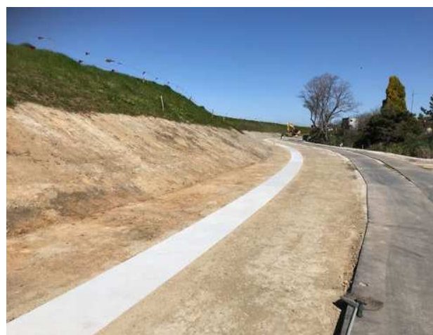
日光川の耐震工事（矢板打設完了）（蟹江町）
