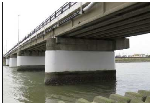
(主)豊橋渥美線(紙田川橋) 橋脚の耐震補強(豊橋市)
