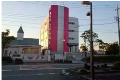
津波避難ビル (弥富市南部地区防災センター)
