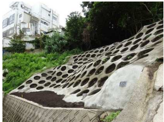
植生基材の吹付けによる早期緑化の促進 (南知多町赤石地区)
