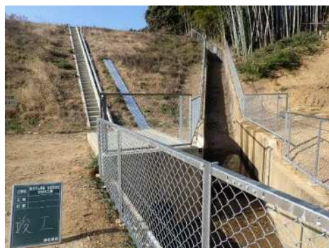
ため池の洪水吐改修（中根池）
