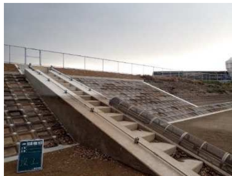
ため池の耐震対策(中根池)緊急放流工
