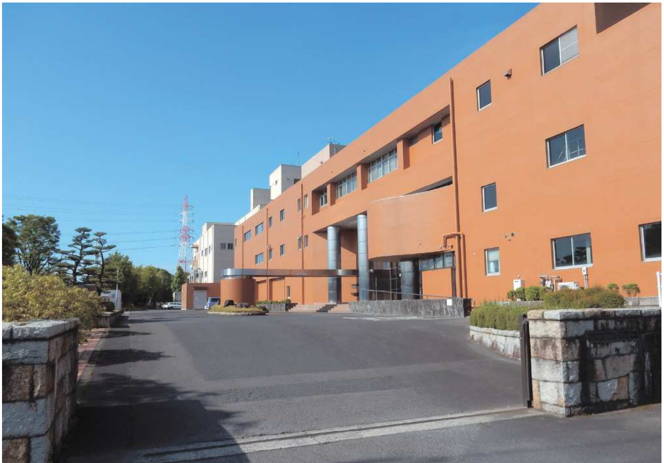
浄化センター管理本館
