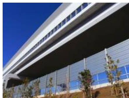
遮音壁の設置事例
