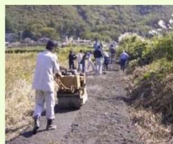
未舗装農道の舗装
