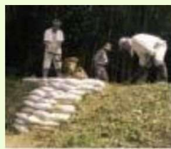
漏水箇所の補修
