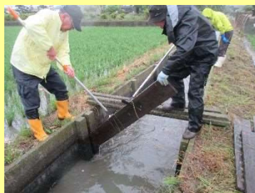
止水板を利用した排水管理
