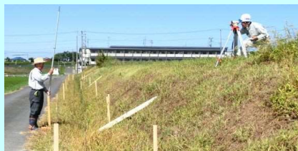
構成員により測量する様子
