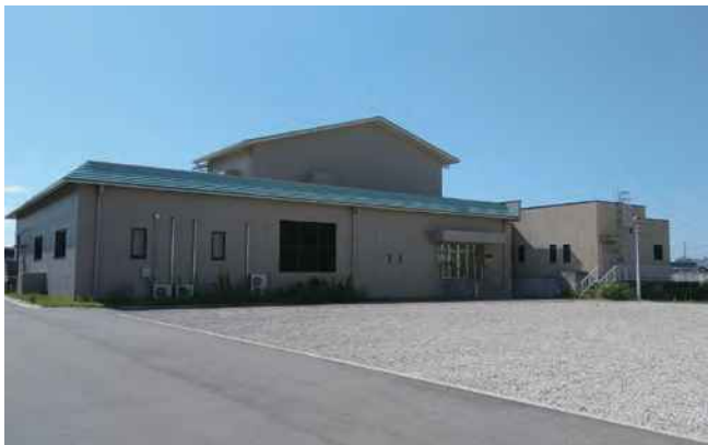
流入ポンプ棟
