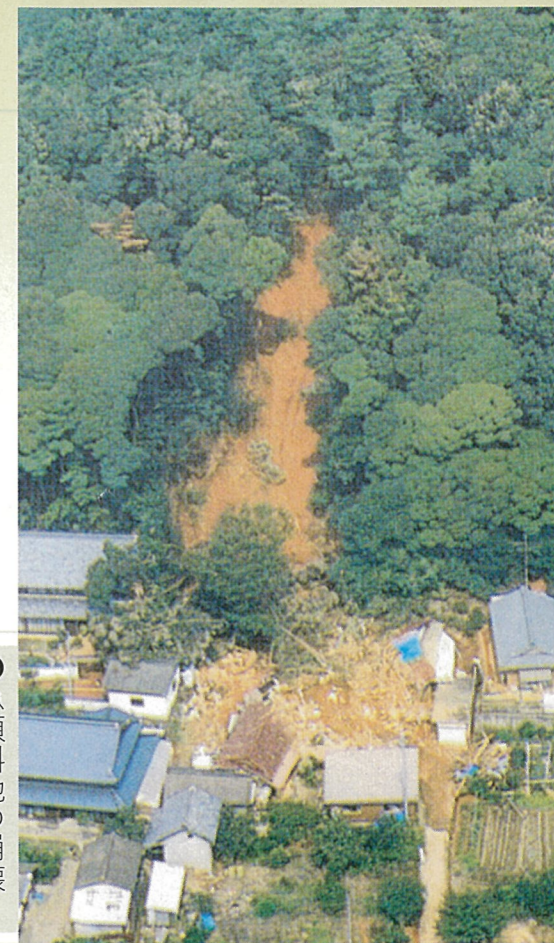
●急傾斜地の崩壊 (かけ崩れ) 平成12年 大山地区(小牧市)
