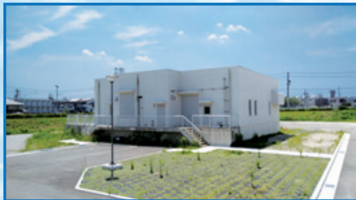
揚水ポンプ棟
