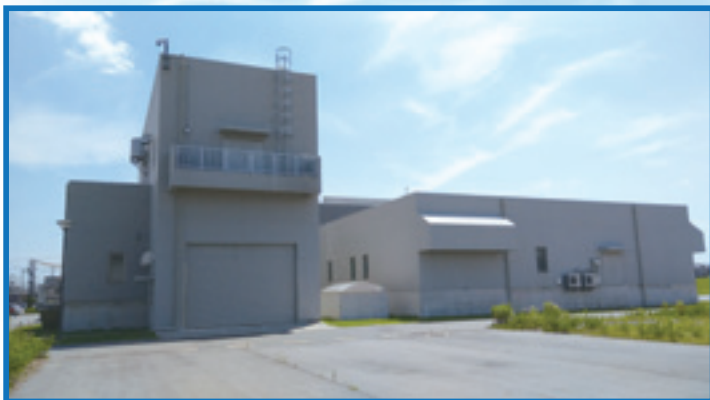
流入ポンプ棟
