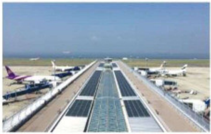
＜太陽光パネル発電（第1ターミナルビル）＞
