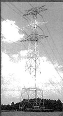
送電線(27万5,000ボルト) (測定ポイント:地表1.5m) 10.1マイクロテスラ
