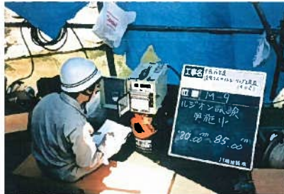
ルジオン試験状況写真
