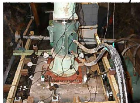
基礎岩盤のせん断試験の様子
