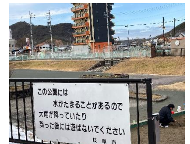
大雨の時、調整池となる公園 (岐阜市日野橋公園)
