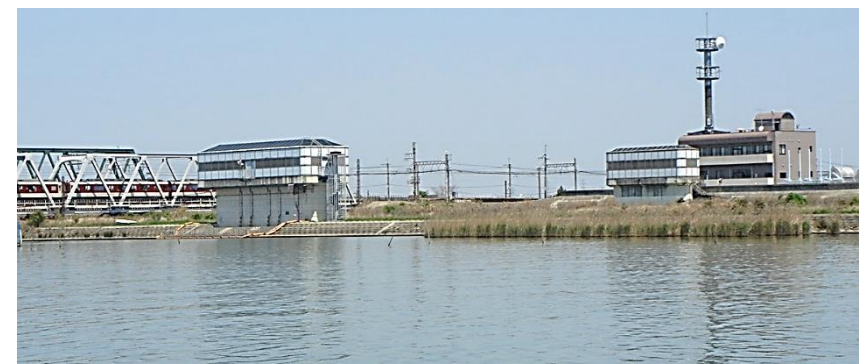
長良導水取水口 (愛知県知多地域の水道水源として導水されている)
