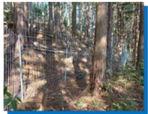
柵のかさ上げの様子
