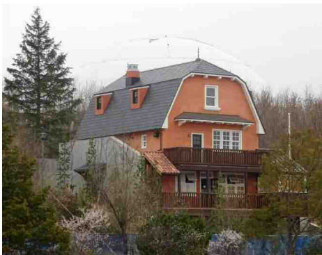
建物が概成し、5月頃から現地での演示工事
