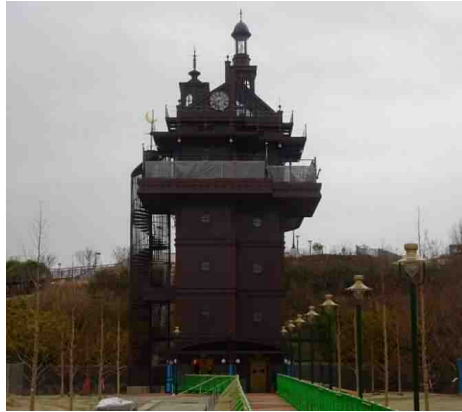
3月23日からエレベーターの利用を再開
