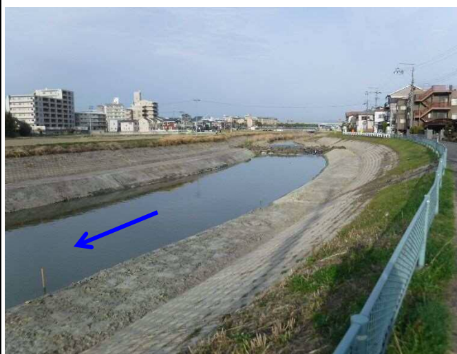
④猿渡川：河床掘削工 （弘法橋上流部）
