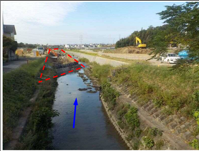
⑤逢妻男川：護岸工 (交角橋付近)
