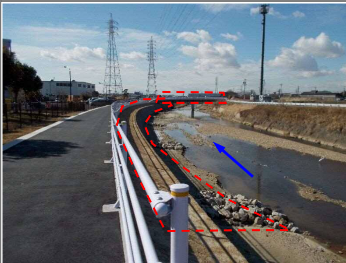
⑦逢妻女川：護岸工 (伊勢堤橋付近)
