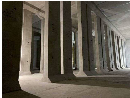
4号調整池 (内部)
