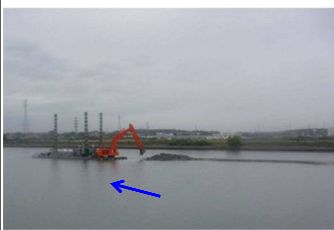
①境川・逢妻川： 背割堤（中堤）撤去工
