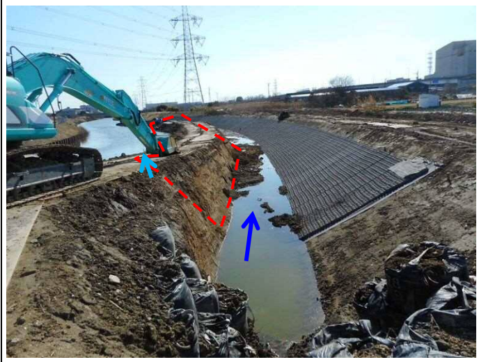
⑨五ヶ村川： 背割堤（中堤）撤去工
