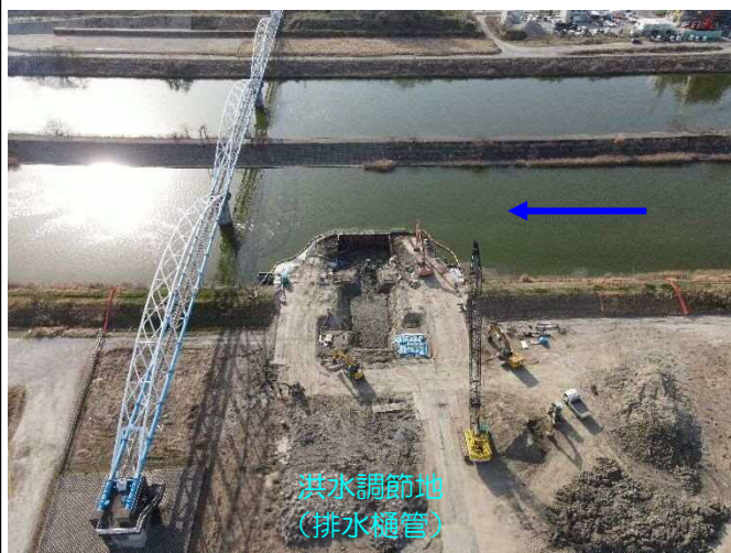
③逢妻川：洪水調節地関連工 （排水樋管）
