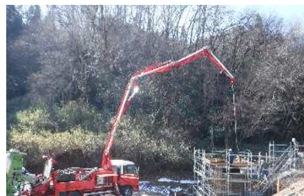
洪水吐兼取水施設コンクリート打設
