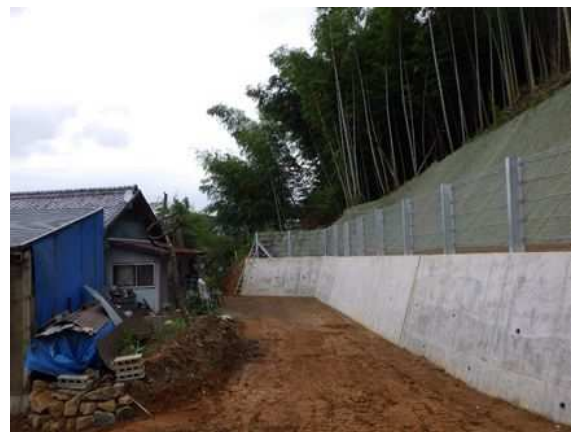
土留工（犬山市）
