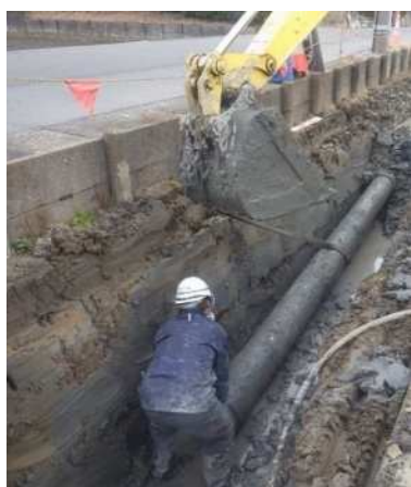
農業用用水路の石綿管撤去 (名古屋市港区)
