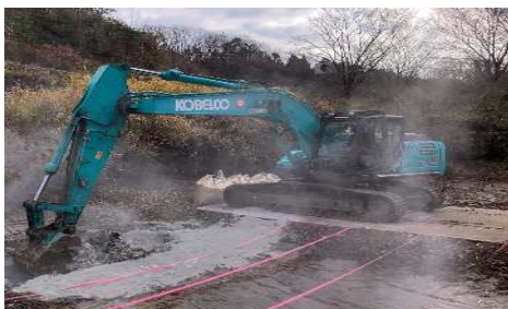
地盤改良工事
