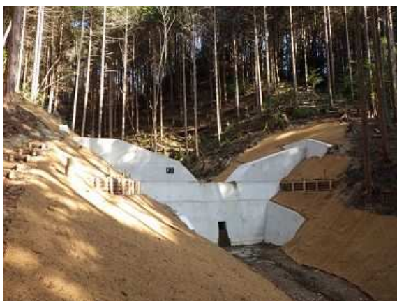
谷止工（瀬戸市）
