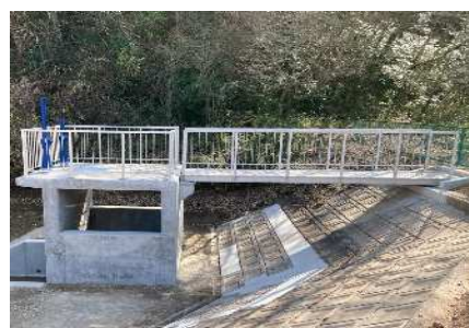
完成した洪水吐兼取水施設
