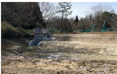
完成した堤体
