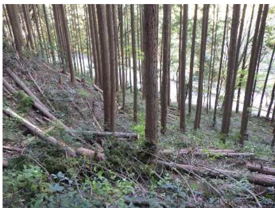
治山事業 森林整備 (瀬戸市)
