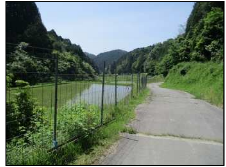
設置された防護柵（岡崎市）
