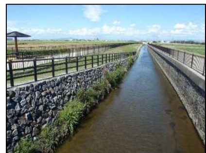
かんがい排水事業 中井筋依佐美地区（安城市）
