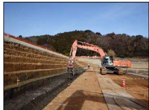
防災ダム事業 小草池地区 堤体耐震補強工（西尾市）
