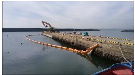
保全工事を行っている防波堤（西尾市）
