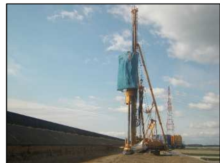
碧南2期地区 堤防耐震補強工（碧南市）
