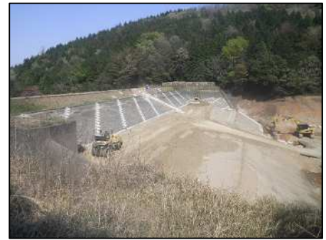
宝谷池地区 堤体補強工（幸田町）
