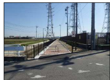
水環境整備事業 中井筋2期地区にて 整備した遊歩道（安城市）
