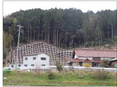
法枠工（幸田町）
