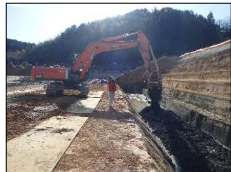
小草池地区 堤体補強工（西尾市）
