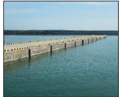
保全工事を行った防波堤
