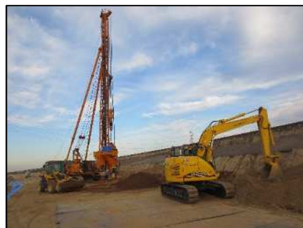
碧南2期地区 堤防耐震補強工（碧南市）
