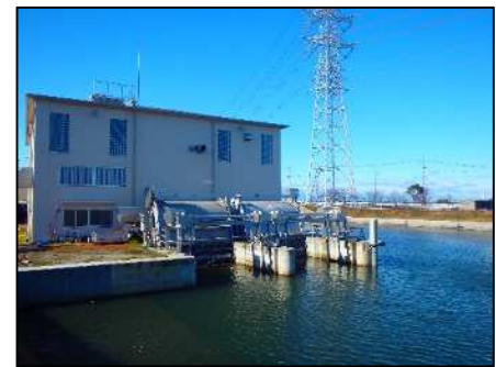
北浜川排水機場（西尾市）
