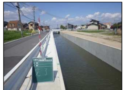
かんがい排水事業中井筋地区(刈谷市)
