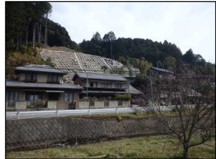
法枠工（岡崎市）
