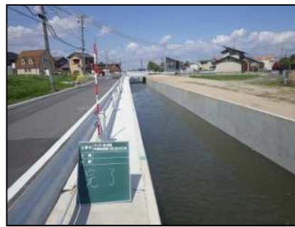
かんがい排水事業中井筋地区 (刈谷市)
