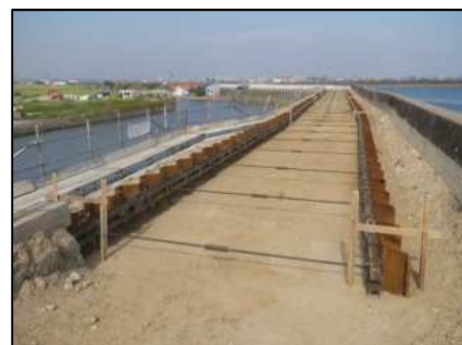
奥田海岸 鋼矢板工（西尾市）
