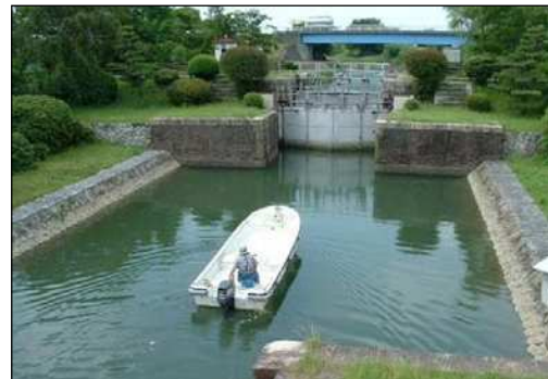
□船頭平閘門(愛西市)
