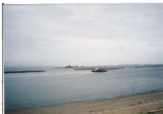
造成中の干潟・浅場
