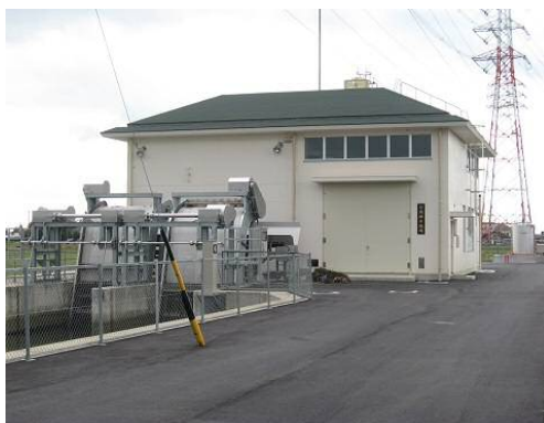
農業用排水機場（西尾市）
