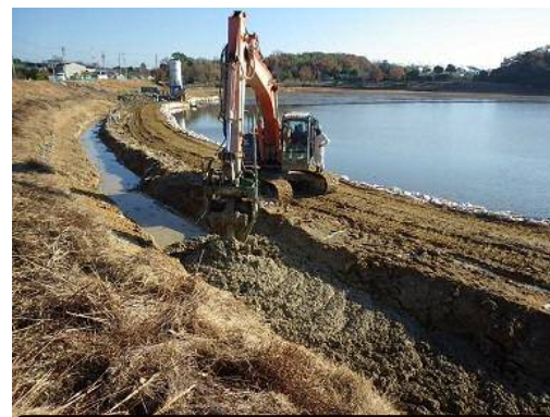
ため池の地盤改良工事（刈谷市）
