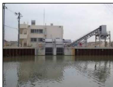
新前新田排水機場(正面)
