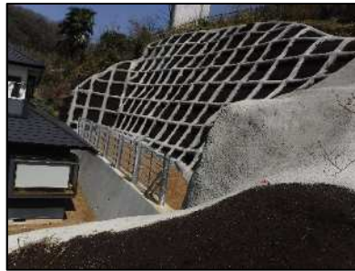
土留工と簡易法枠工(岡崎市)
