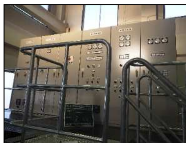
ポンプの電気設備の更新
