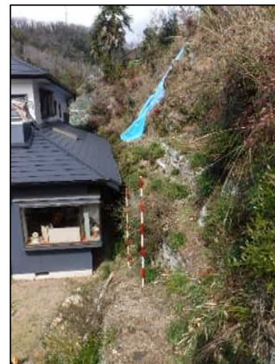
施工前の状況
