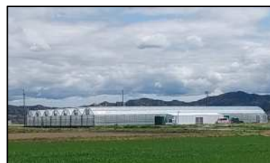
幸田町なすハウス全景
