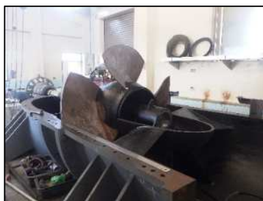
分解整備されたポンプの据付状況
