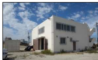
新前新田排水機場(建屋)
