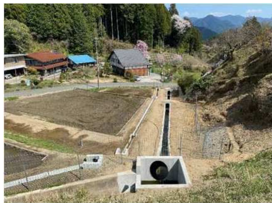
水路の整備（設楽町田峯地区）
