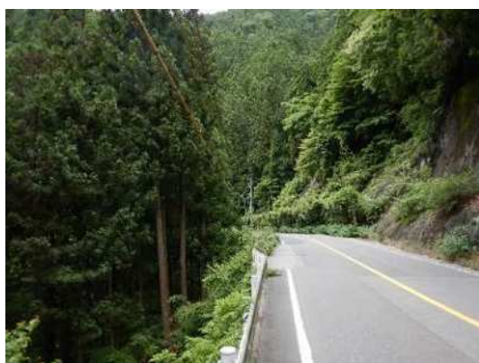
国道 151 号線 整備前（豊根村）
