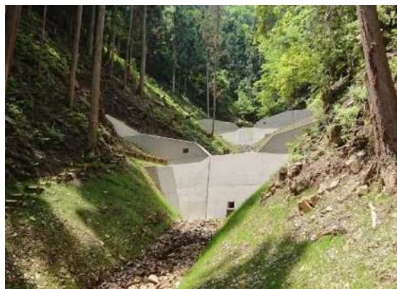
谷止工（東栄町）
