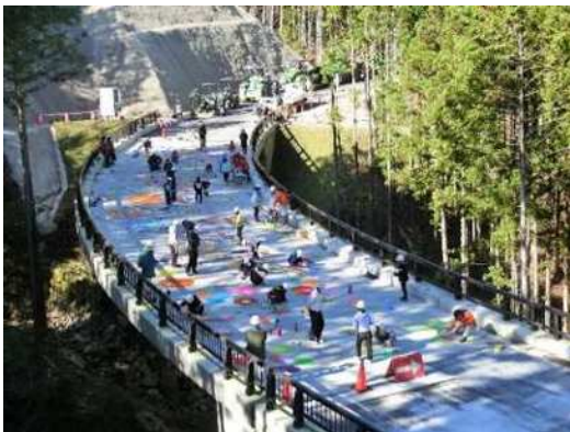
橋面ペイントの様子
