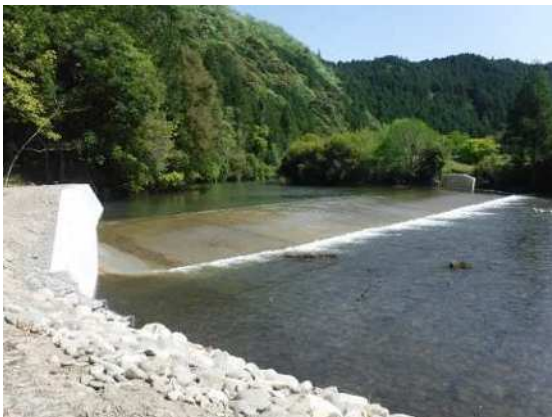
取水堰の整備（新城市布里地区）
