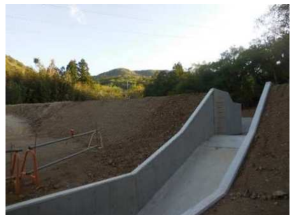
洪水吐の整備（新城市富岡東部地区）
