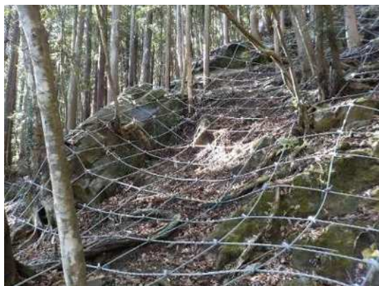
落石対策 固定工（新城市）
