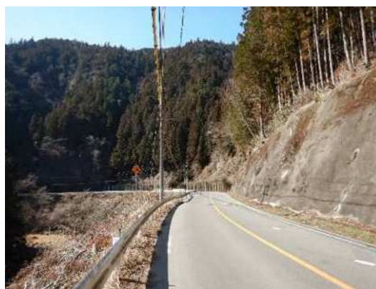
国道 151 号線 整備後（豊根村） ※電線や道路に架かる立木を伐採
