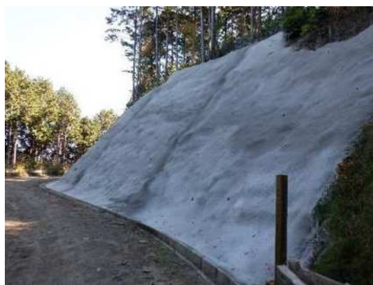
小規模林道事業（改良） 三都橋線（設楽町）
