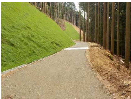
過疎山村地域代行林道事業 西園目御園線2工区工事（東栄町）
