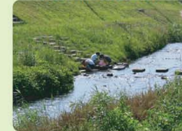
音羽川の多自然型川づくり(音羽町)
