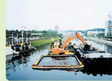
堀川の浚渫(名古屋市)
