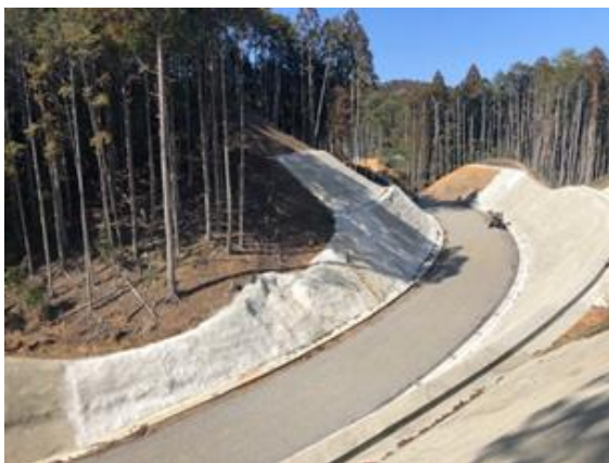
国道257号（設楽町）
