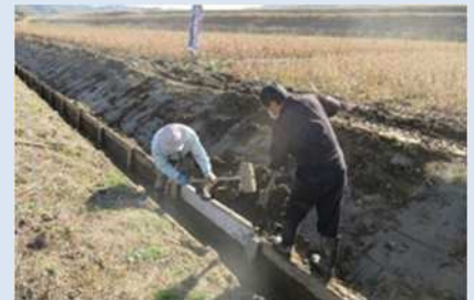
活動組織による水路の補修
