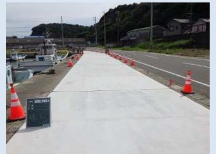
老朽化した物揚場の補修(師崎漁港)
