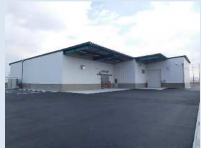
大葉の集出荷貯蔵施設
