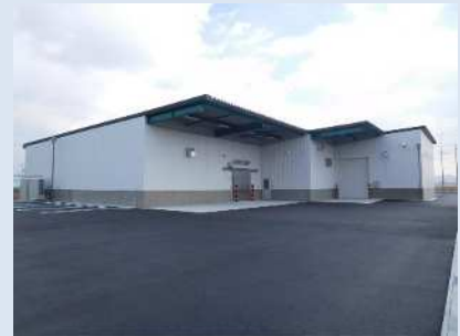
大葉の集出荷貯蔵施設
