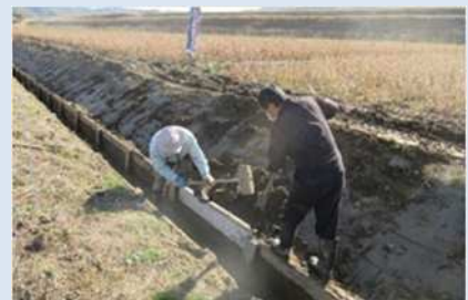
活動組織による水路の補修
