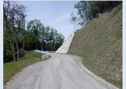
林道の開設(豊田市)
