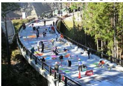
橋面ペイントの様子（設楽町）
