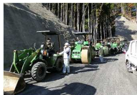
建設機械の乗車体験（設楽町）
