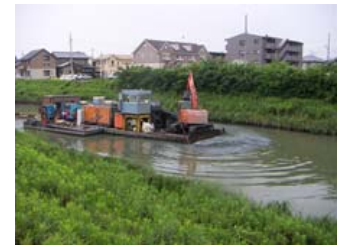
浚渫施工状況
