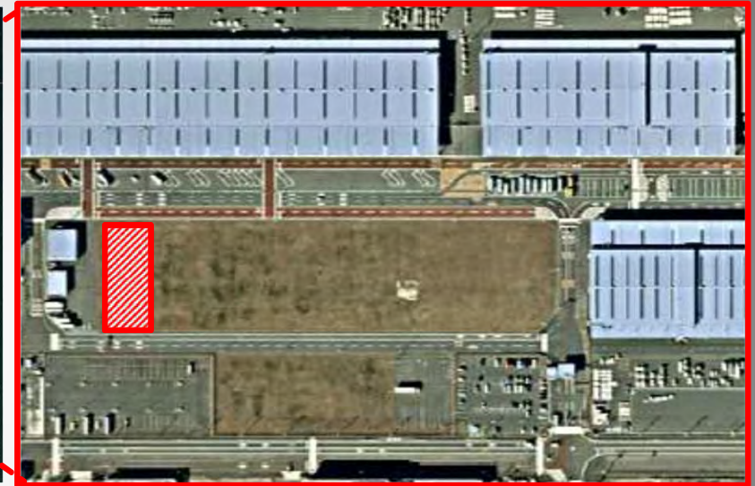
設備設置場所
