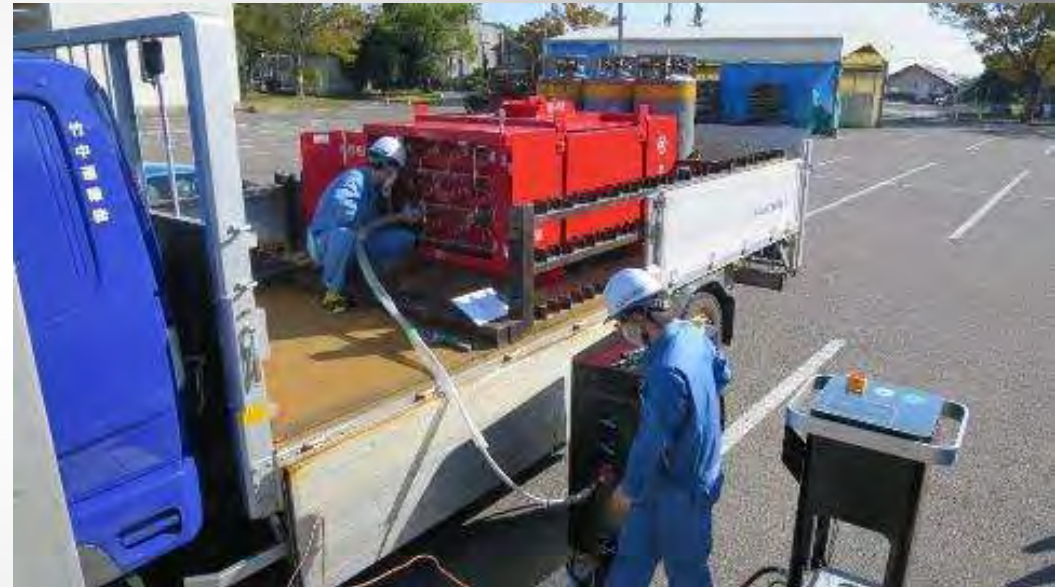
45MPaカードル接続作業
