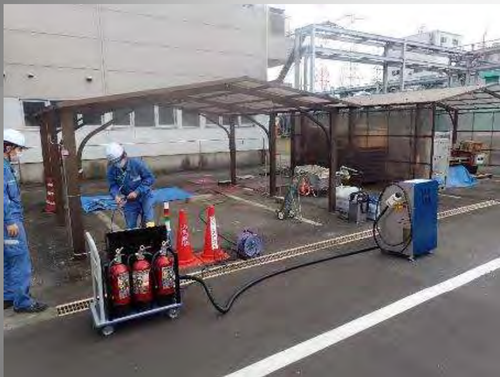
充填機と制御盤の配管・ケーブル接続作業
