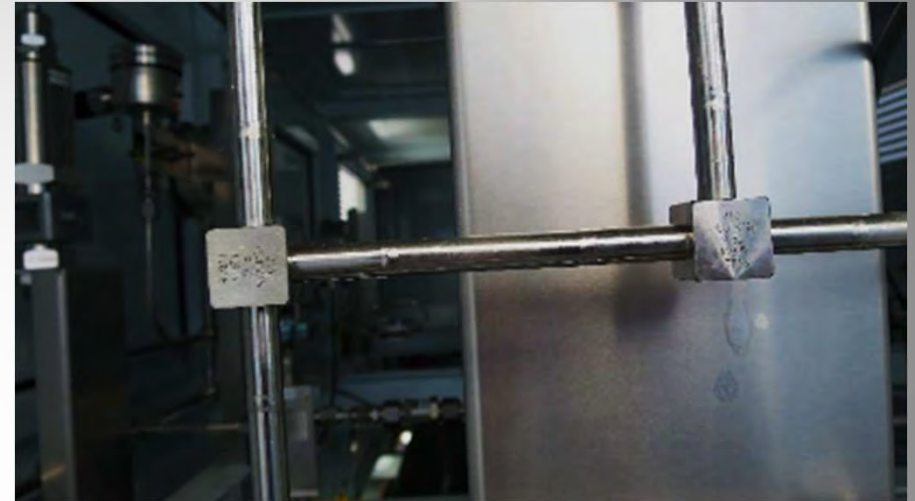
溶接施工による配管
