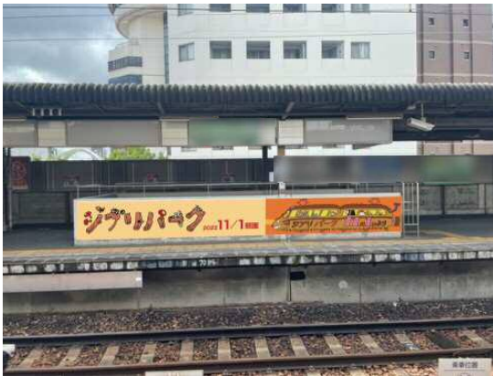
③ホームの階段腰壁
