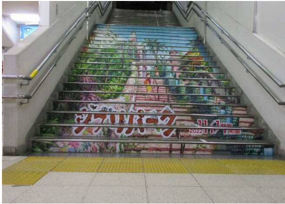
①ホームとの階段段差
