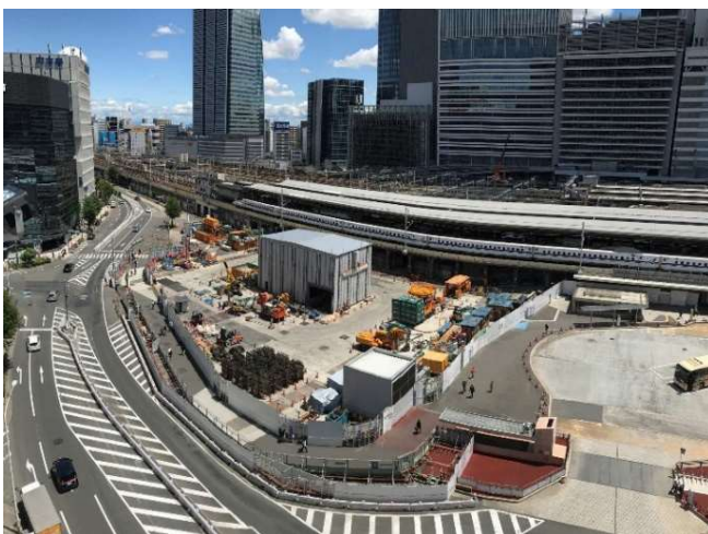
【名古屋駅（中央西工区）】
