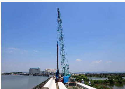
【豊橋海岸 鋼矢板打設状況】
