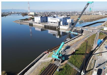
【日光川 鋼矢板打設状況】
