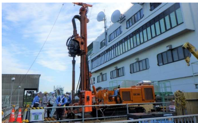
【排水機場の基礎の耐震化】
