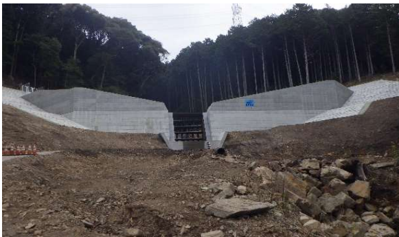
【砂防堰堤の整備】
