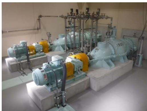
【整備完了状況】
