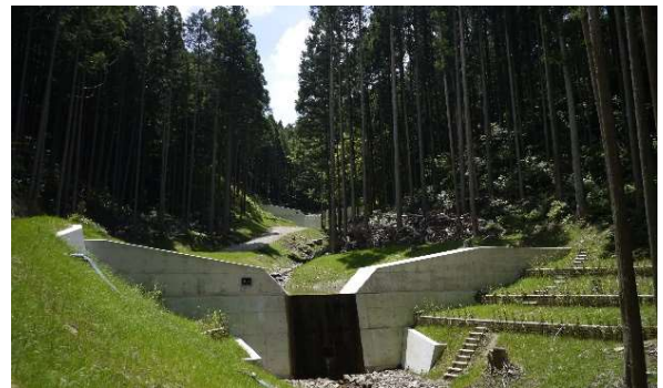
【治山施設の整備】
