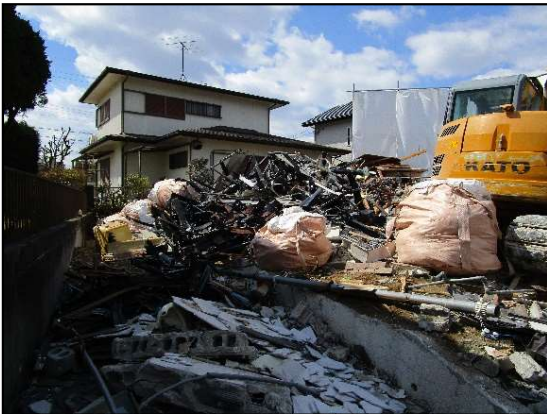
【解体工事現場の様子】
