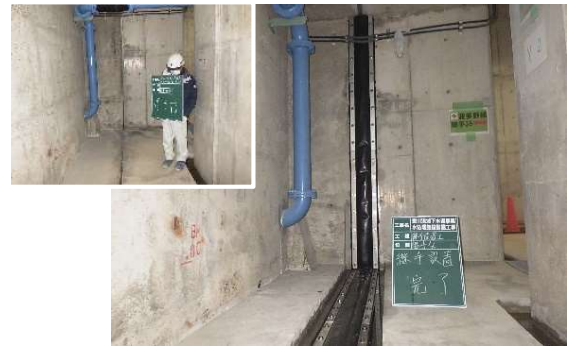
【処理場施設の耐震化】
