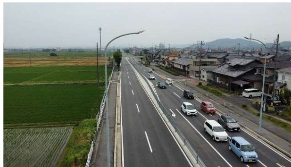
【主要地方道岡崎碧南線】 (岡崎市)
