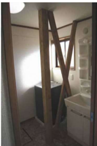
【戸建住宅の耐震改修】
