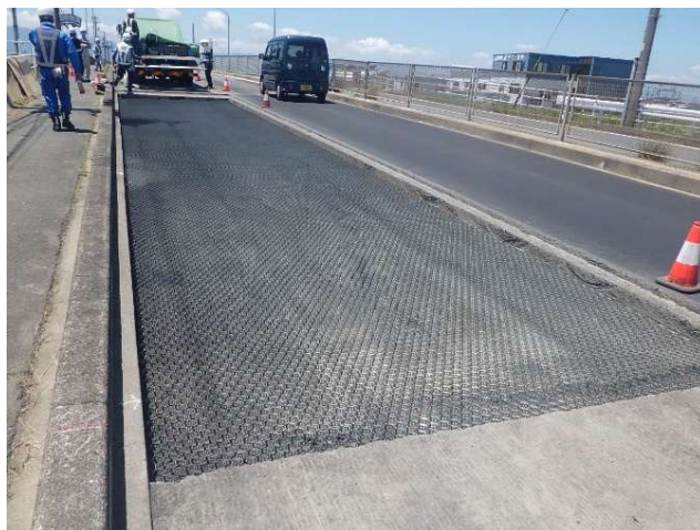
【（主）あま愛西線・ゴハチ橋】
