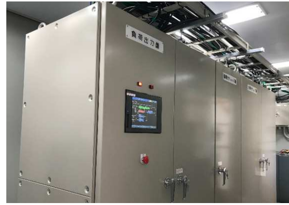
C : 負荷電源盤、太陽光チャッパ盤、蓄電池チャッパ盤、監視用PC
