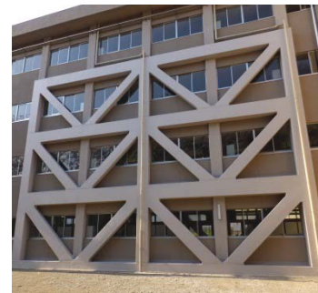
【耐震補強の例】
