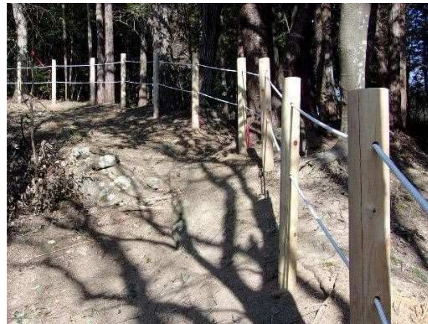
散策路整備（ロープ柵工等の設置）
