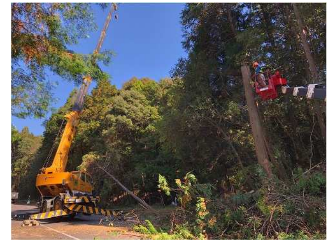
高所作業車及び クレーン使用（新城市）
