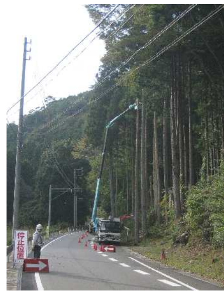
高所作業車使用（豊田市）
