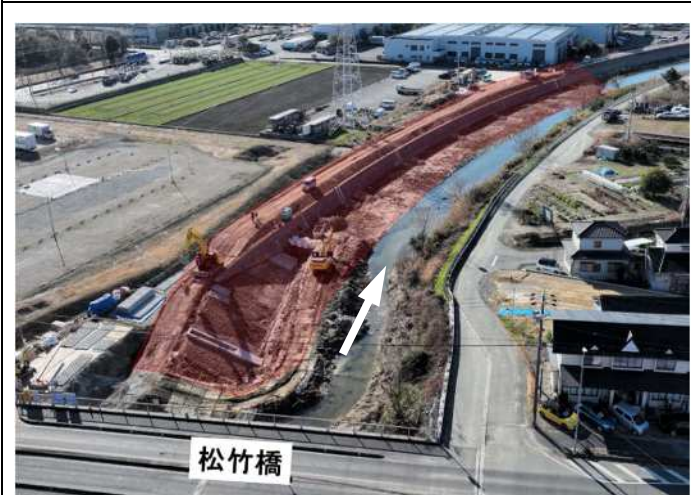
⑦逢妻女川：護岸工実施状況 (松竹橋付近)
