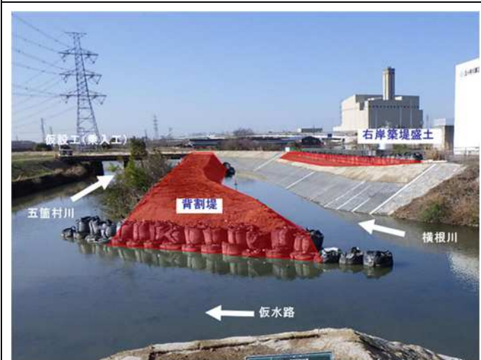
⑨五箇村川： 背割堤（中堤）撤去実施状況
