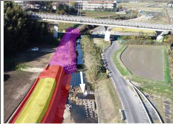
⑤逢妻男川：護岸工実施状況 (逢初橋下流)
