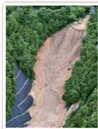
廃棄された土石の崩落により 死者1名、重傷者1名 住宅被害1棟
