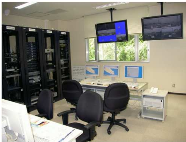
津波・高潮防災ステーション室内
