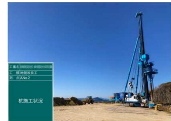
渥美海岸海岸堤防(防潮堤)整備 施工状況(地盤改良)
