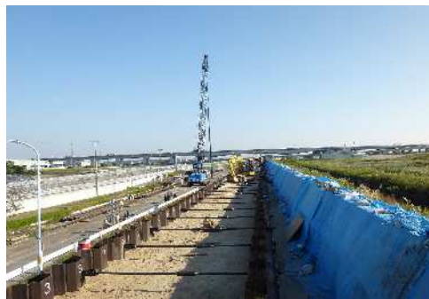
堤防の耐震化 （鍋田海岸（弥富市））
