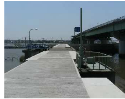
堤防の耐震化 （三河港海岸（豊橋市））
