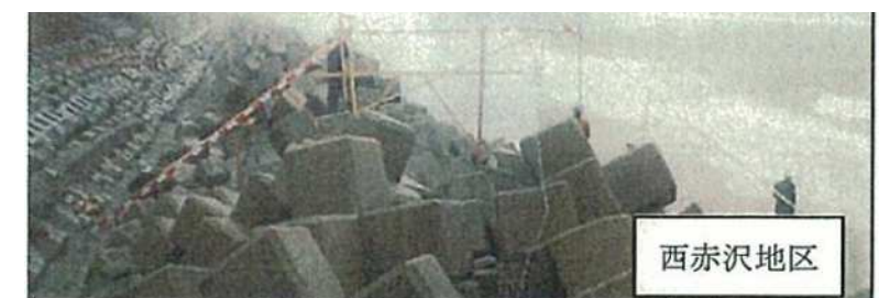
2004年台風16号による消波工の被災状況
