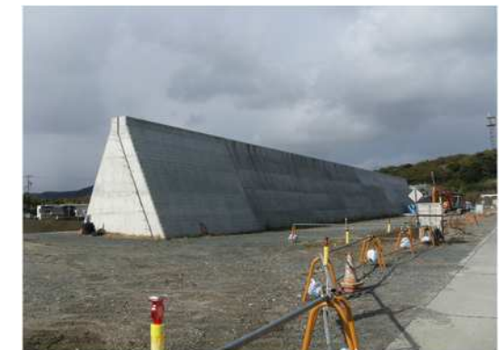
赤羽根漁港海岸 防潮堤施工状況
