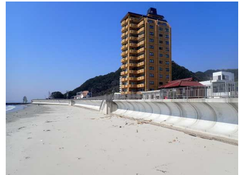
老朽化した既設堤防の前面に大型波返し護岸を設置（南知多海岸）
