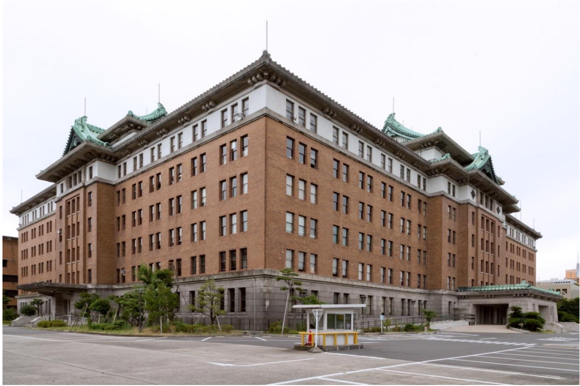
愛知県庁舎外観（西・北面全景）
